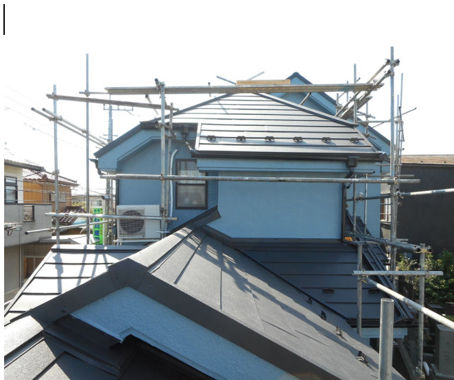
ブルーな外壁に変身しました！
