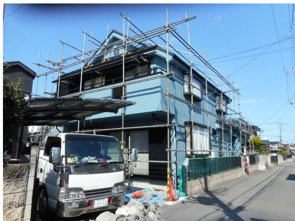
外壁は空の青さより、映える綺麗なブルーです。
