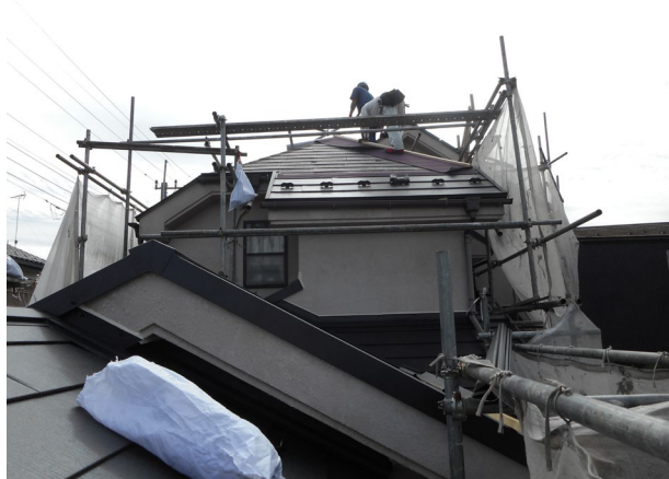
ガルバ鋼板 「ガルテクト」 工事中！
