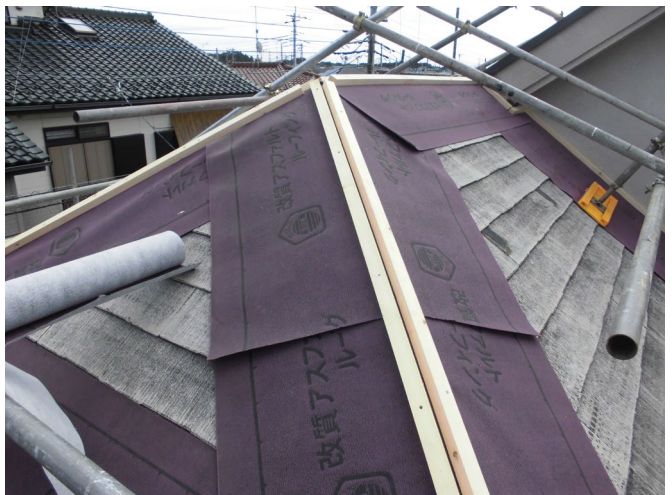
ゴムアスルーフィングを張り、工事開始
