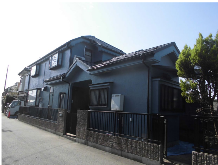
リフォーム工事 完了しました ♪
